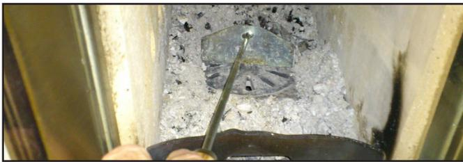
Anheizrost mittels Ziehvorrichtung, die sich unter dem Feuerraumboden befindet, zu öffnen.
